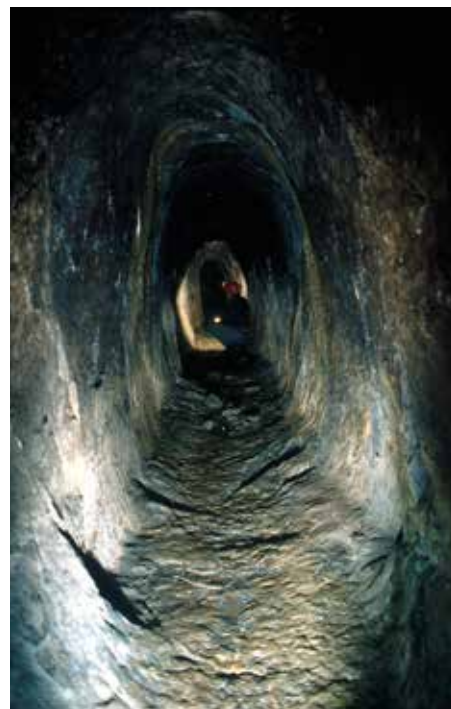
Galleria mineraria di Pramosio
